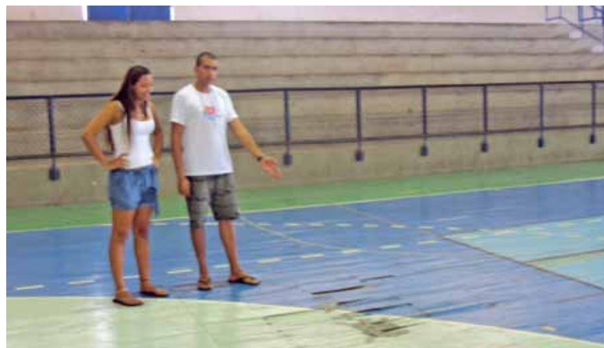
Estudantes apresentam piso do ginásio de esportes danificado devido a goteiras.
